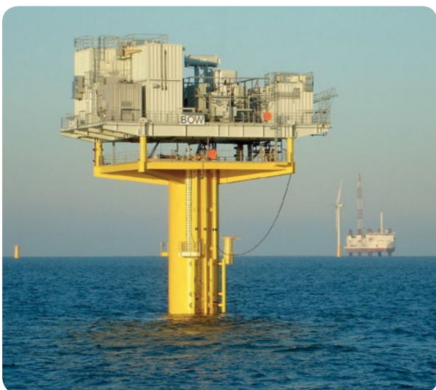
Umspannplattform der britischen Barrow Offshore Wind Farm. Quelle: wikipedia
