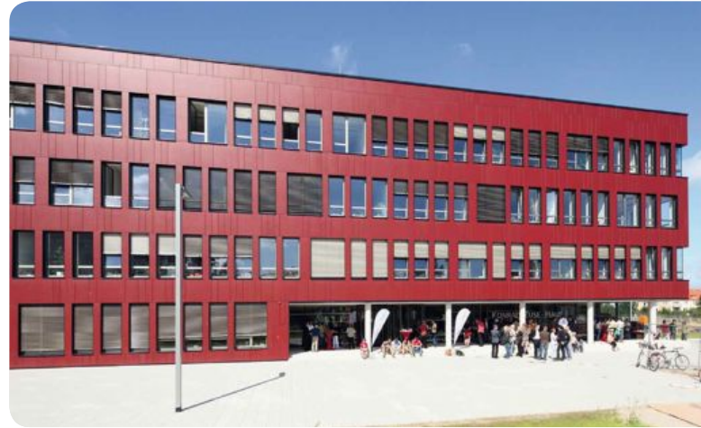
Konrad-Zuse-Haus – das neue Gebäude für das Institut für Informatik und das IT- und Medienzentrum
