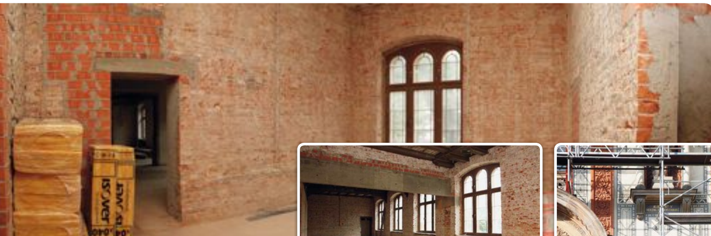
Sanierungsarbeiten am Universitäts- hauptgebäude
