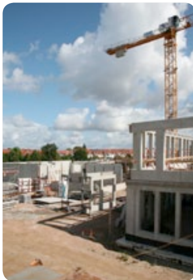
Der Neubau des Instituts für Informatik mit Rechen- und Medienzentrum in der Südstadt wächst.
