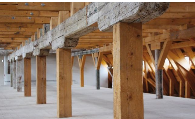
oben: Renovierter Dachstuhl im Kornhaus Zwickau.
