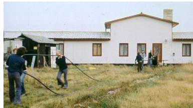
Fast fertig. Noch ein paar Kabel verlegen...Foto: bereitgestellt H. Baudler
